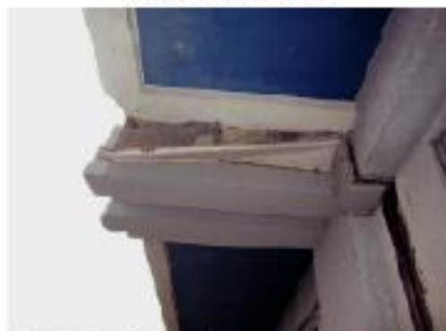
3階外壁（破壊・崩落）
