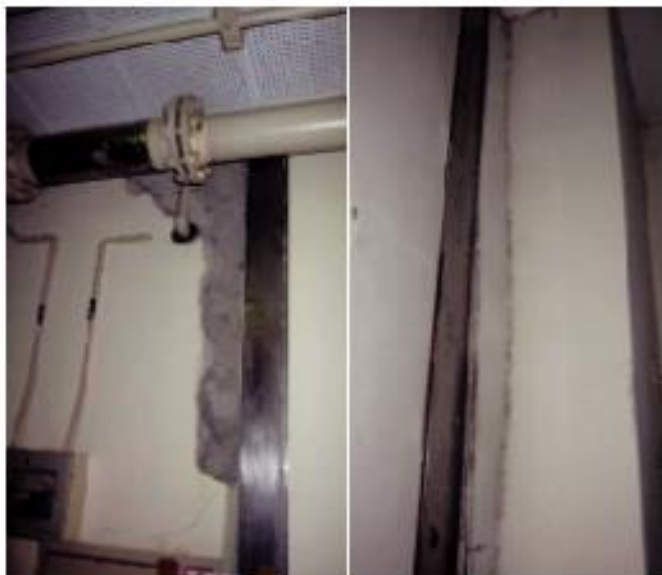
2階エキスパン（破損・ひび割れ）
