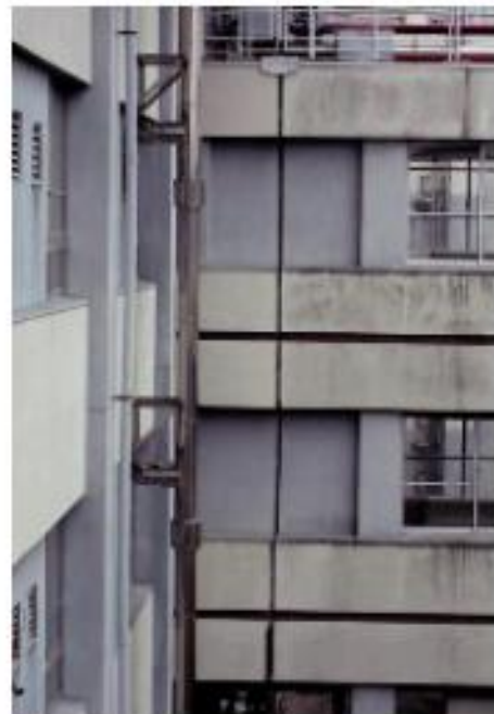
管理棟一病棟渡り廊下接続部 （外壁の開き、崩落）
