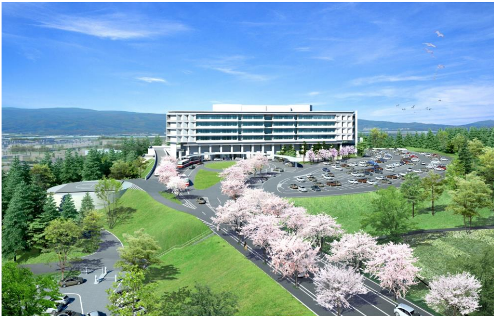
外観 1 アプローチ側より
