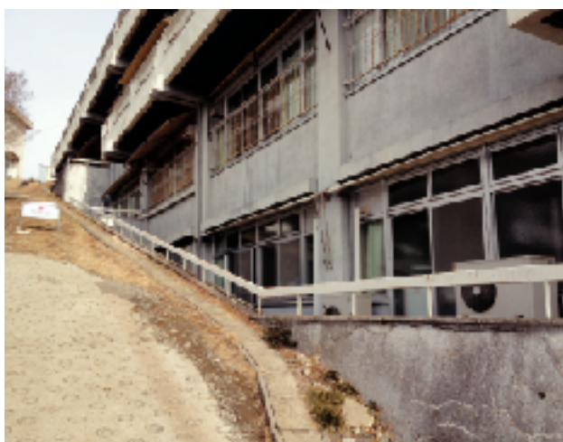
避難経路となった病院脇の坂
