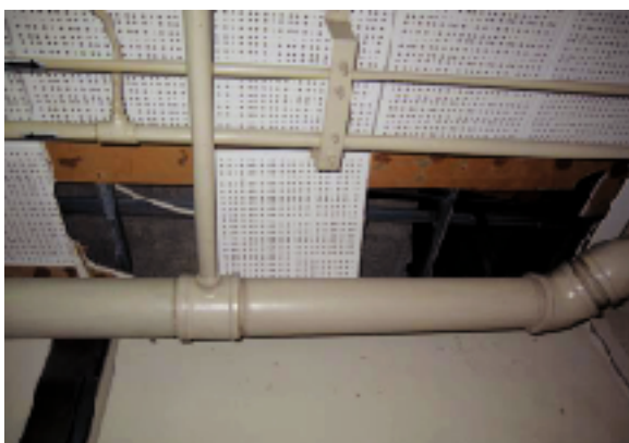
4階天井（崩落）
