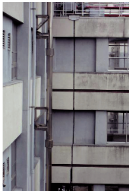
管理棟一病棟渡り廊下接続部 （外壁の開き、崩落）
